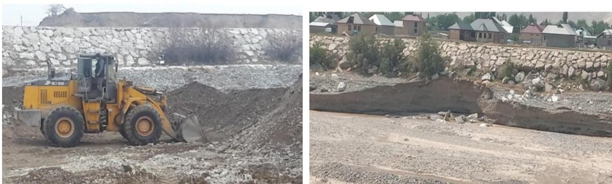
Рис.1. Последствия добычи ПГС на пойме реки Кугарт в районе с. Благовещенка, приводящая к разрушению берегозащитной дамбы.
