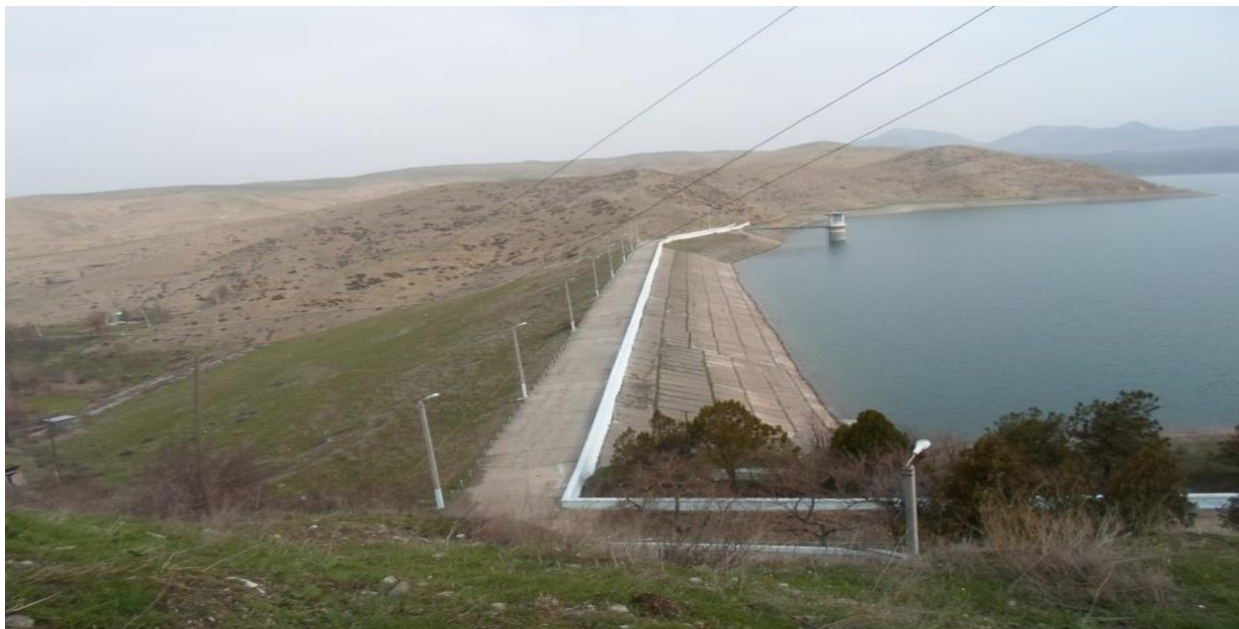
Рис.1: Найманская плотина, вид с севера.
