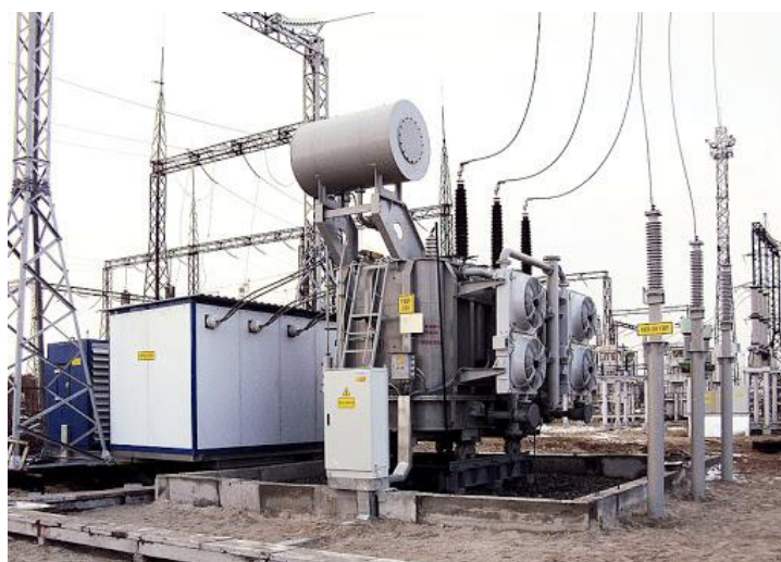
Рис.2. Внешний вид управляемого шунтирующего реактора трансформаторного типа.
