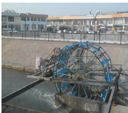
Рис.3. Общий вид Микро-ГЭС- 3 в сборе с передаточными механизмами, генератором и в АКВА помещении
