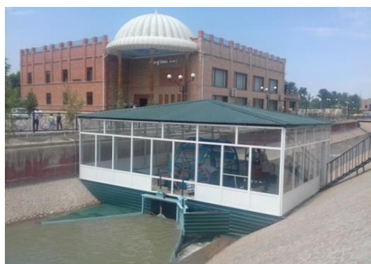
Рис.3. Общий вид Микро-ГЭС- 3 в сборе с передаточными механизмами, генератором и в АКВА помещении
