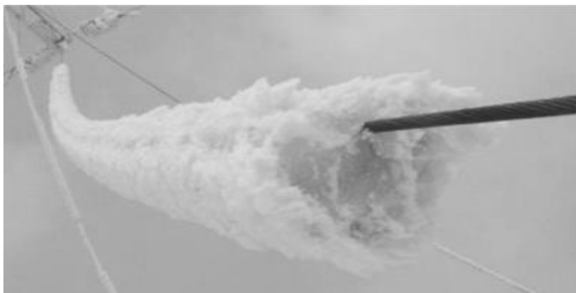
Рис.1 Характерное обледенение провода ЛЭП
