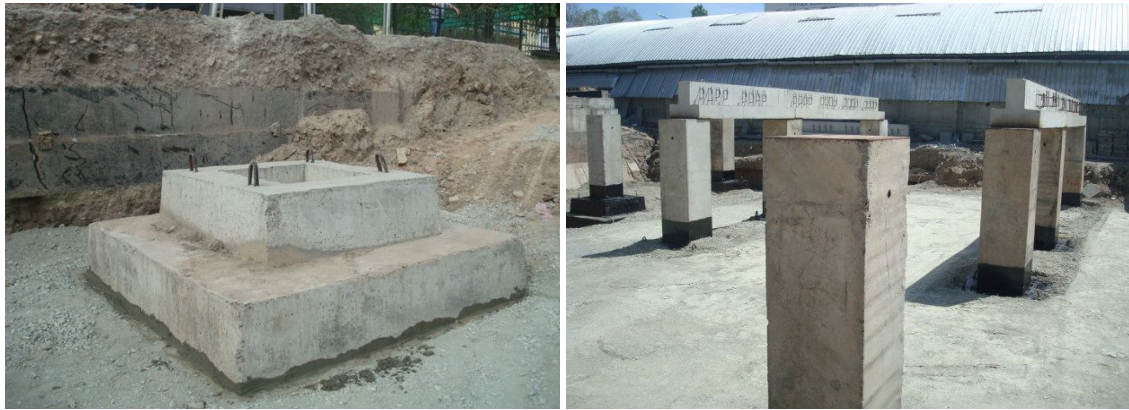
Рис. 1. Возведение искусственного основания промежуточных фундаментов и опор подземного перехода:
